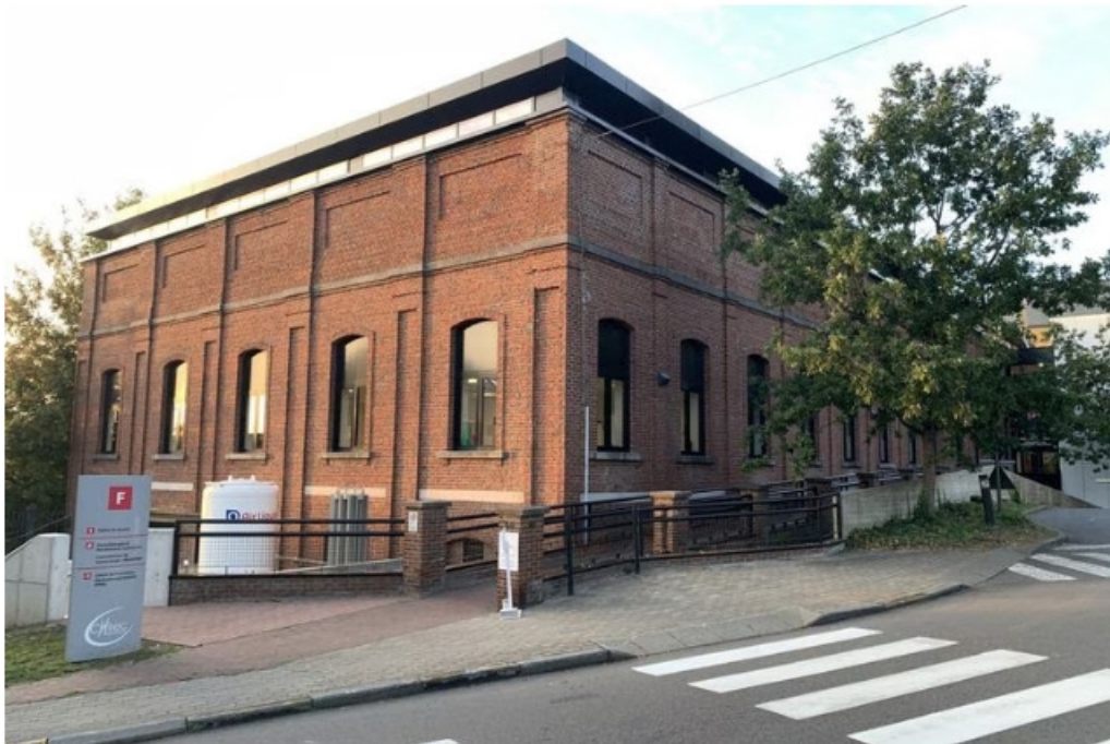
L'ancienne cité administrative communale est devenue le "Bâtiment F" du Chirec. Abritant notamment un centre de PMA, il a été inauguré ce jeudi soir. ©ÉdA - 70180929465
